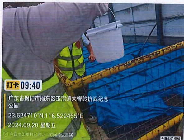
施工 1 标 3#支洞隧道洞口排水
