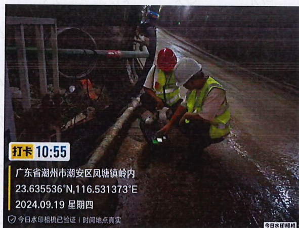
主干线隧洞段 2#支洞 200 米处
