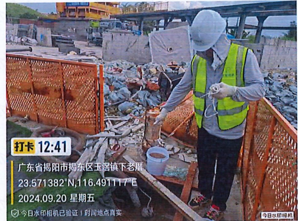
施工 2 标 GX8 生产废水
