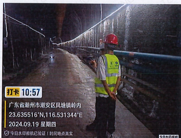
主干线隧洞段 2#支洞 100 米处
