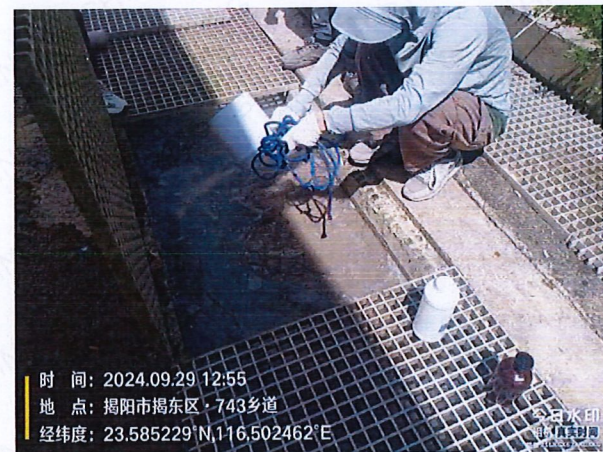
施工 2 标 GX7 生产废水
