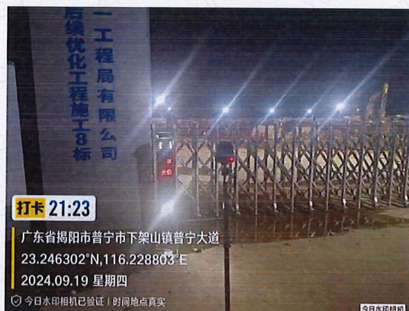
玉丰村 (下架山泵站) 北侧外 1m1#
