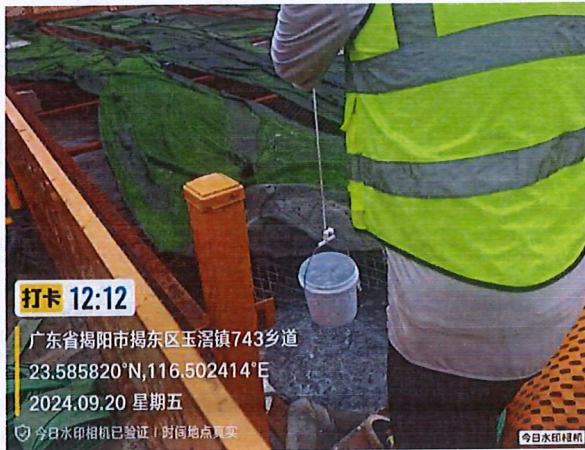
施工 2 标 GX7 生产废水
