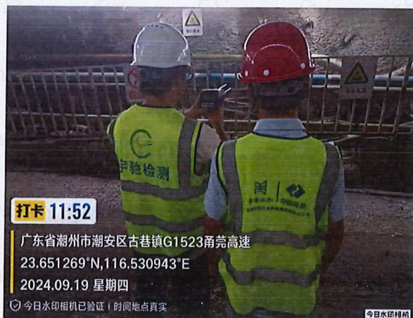
主干线隧洞段 1#支洞 100 米处
