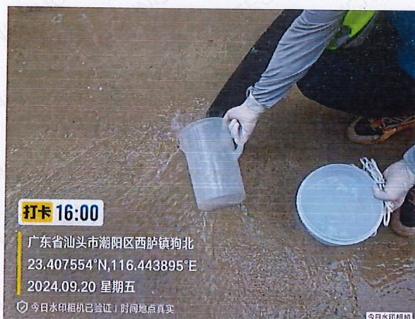
施工 5 标 TBM 隧道开端洞口排水
