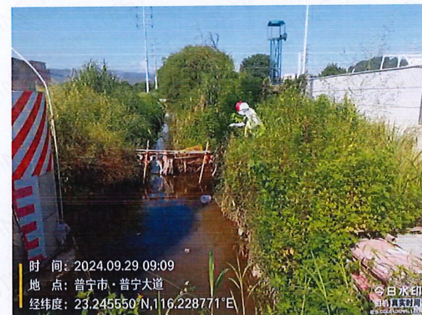
下架山泵站 1 生产废水
