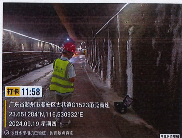
主干线隧洞段 1#支洞 200 米处
