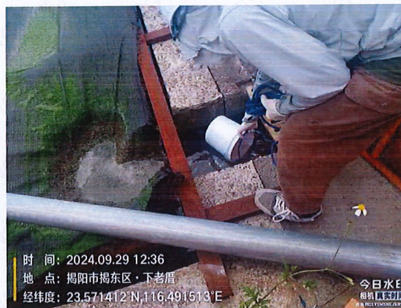
施工 2 标 GX8 生产废水
