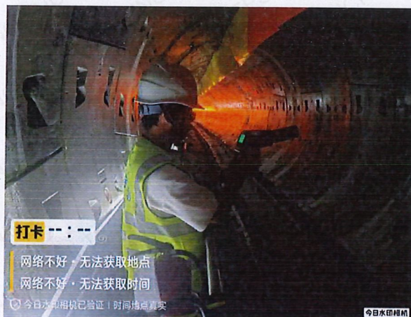
TBM 隧道洞口开端 400 米处
