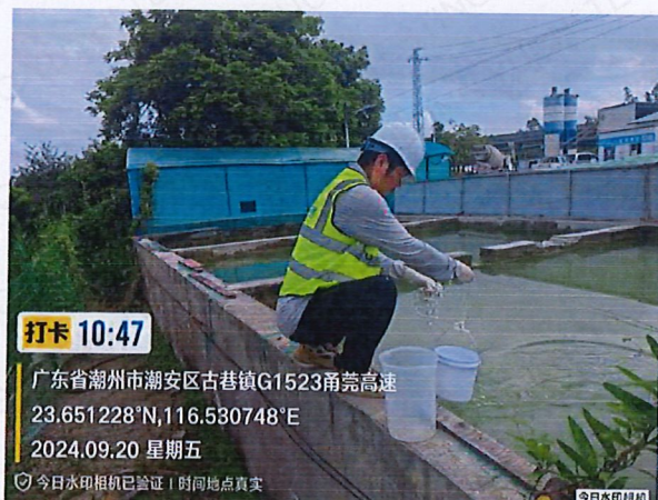
施工 1 标 1#支洞隧道洞口排水
