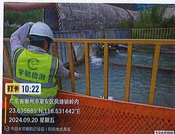
施工 1 标 2#支洞隧道洞口排水
